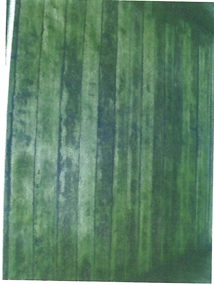
Fot. 4. Widok od spodu przęsta.
