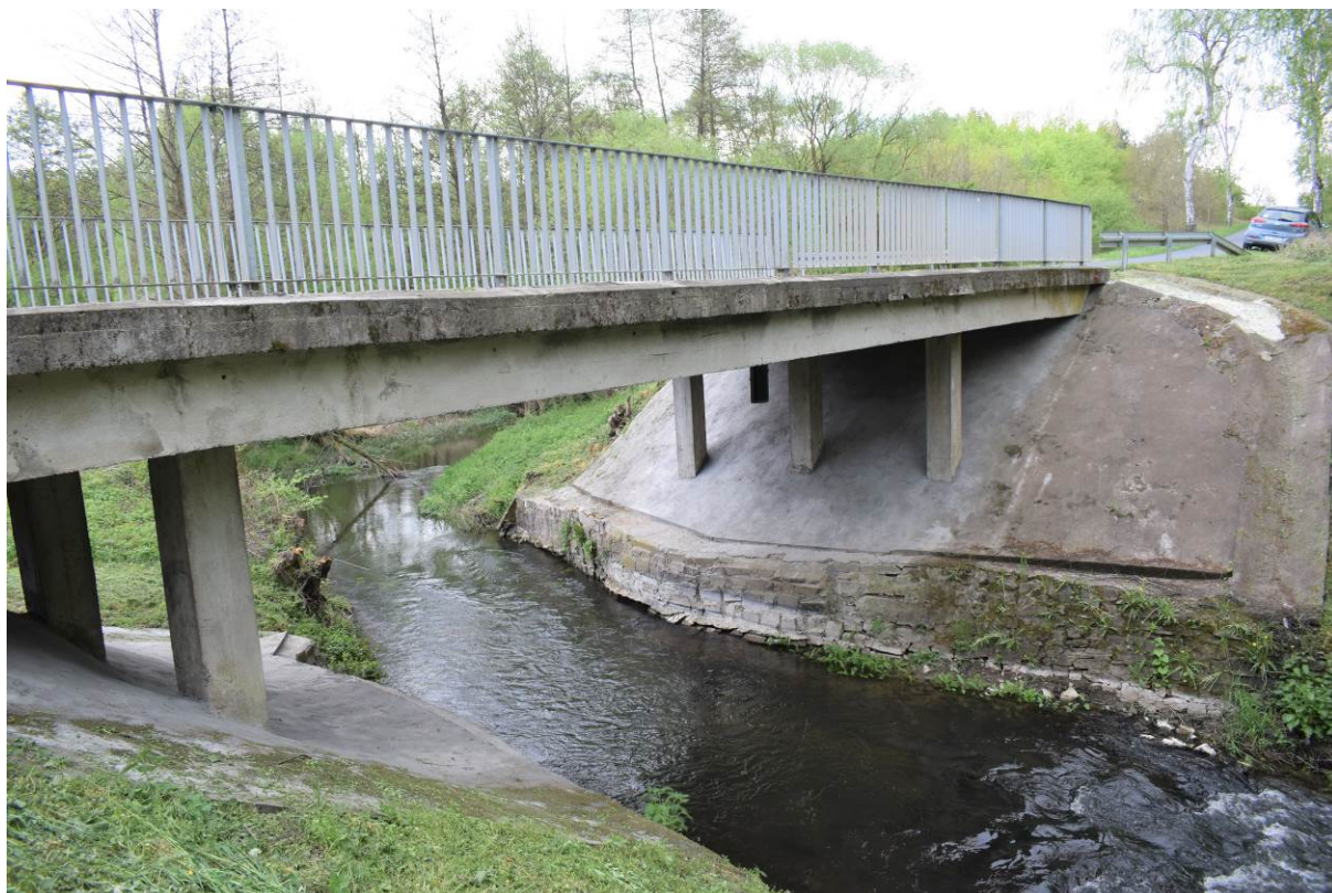
Fot. 1 Widok mostu od strony wody dolnej rzeki (od północy)
