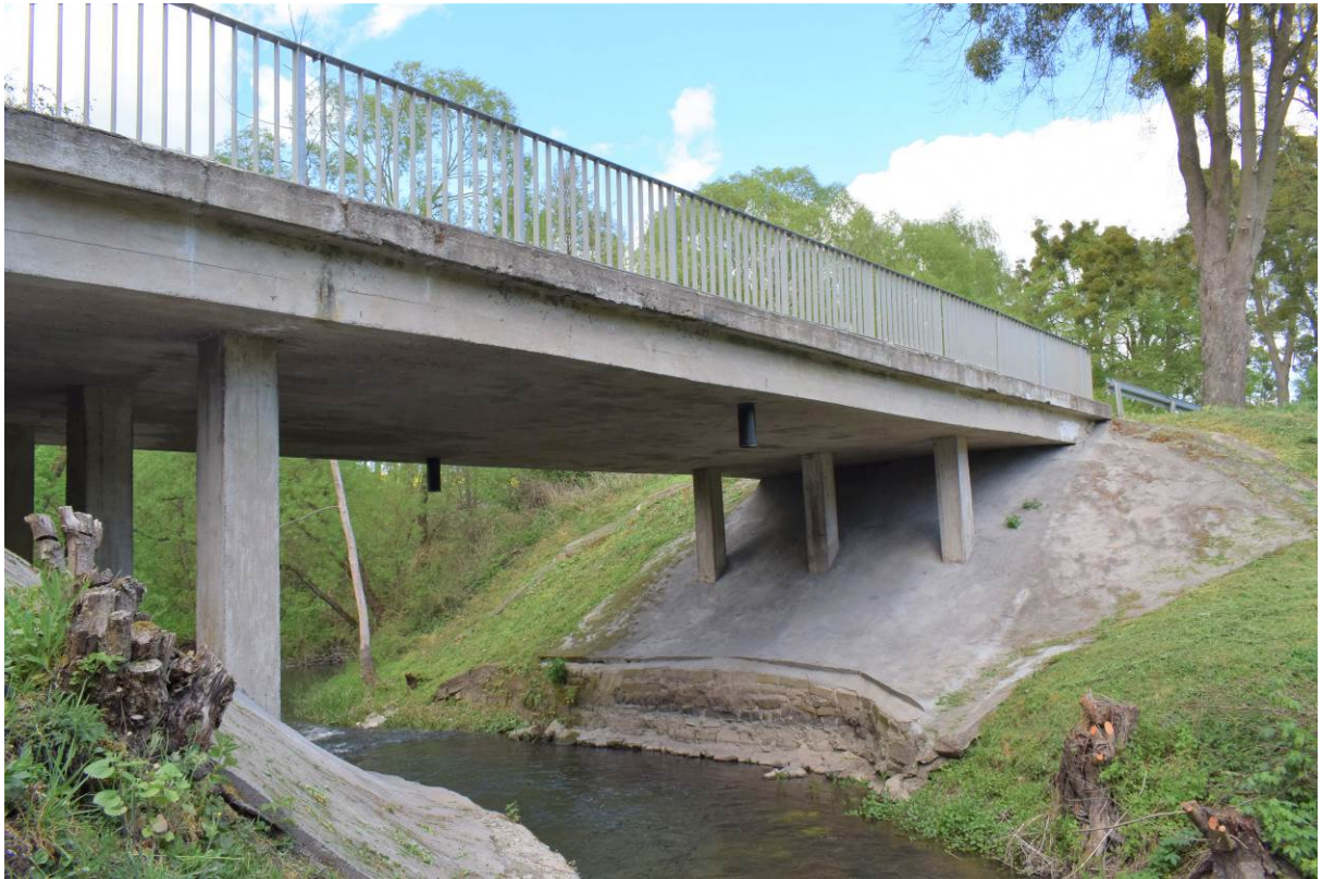
Fot. 2 Widok od strony wody górnej (od południa)
