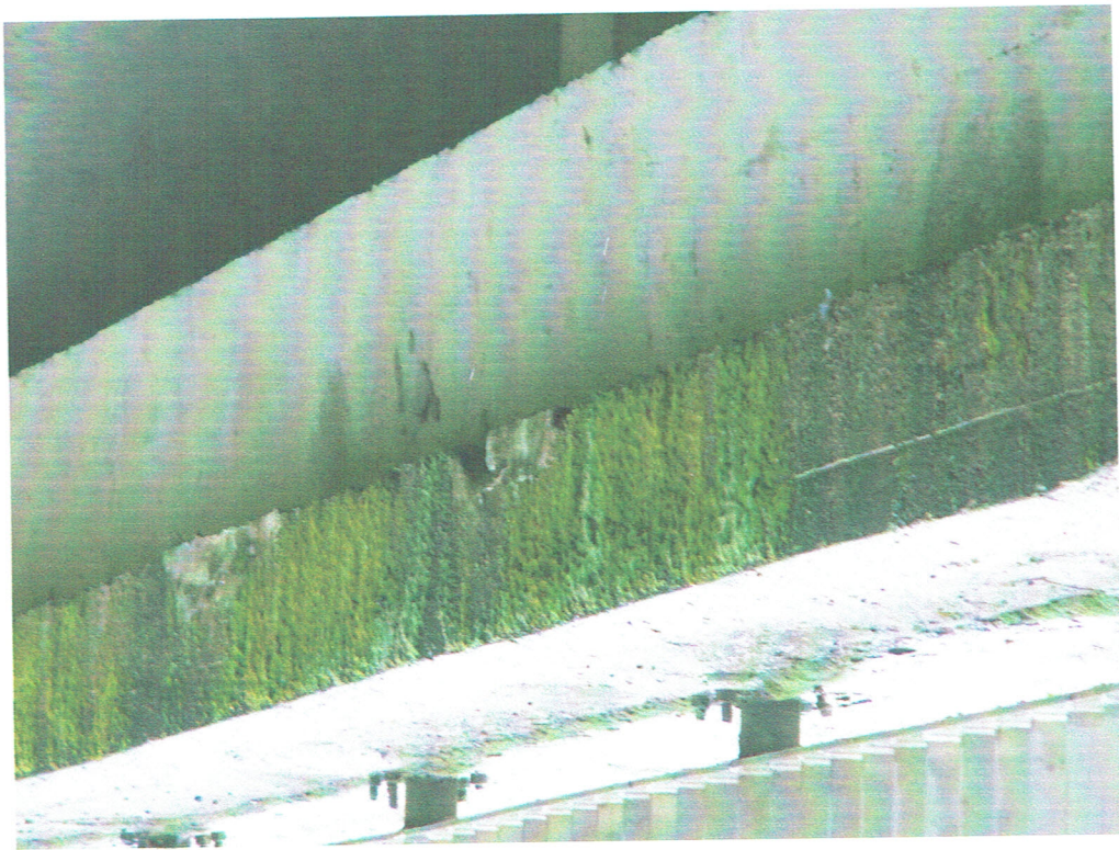
Fot. 9. Porosty mikroorganizmów na całej długości gzymsu.
