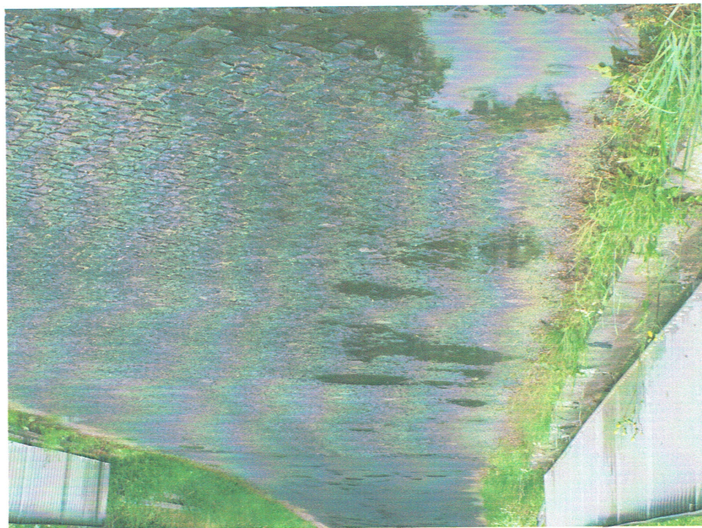
Fot. 5. Nierówności nawierzchni kamiennnej i wegetacja traw na moście.
