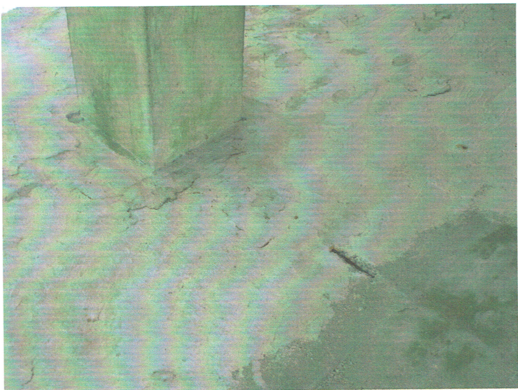
Fot. 12. Lokalny ubytek otuliny i korozja zbrojenia na spodzie płyty przęsła.
