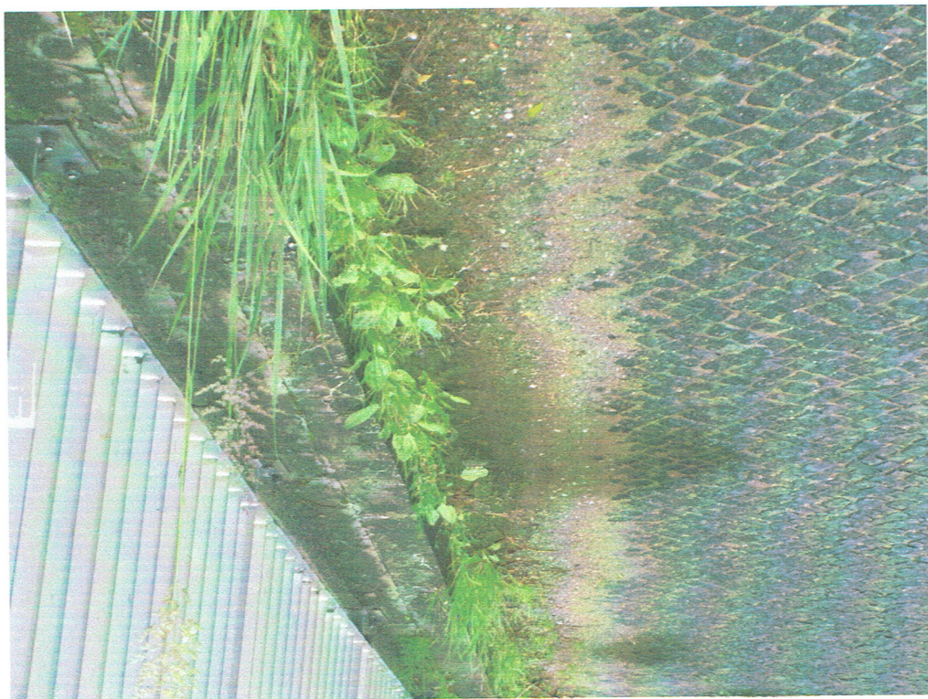
Fot. 6. Piasek i wegetacja roślin wzdłuż opaski bezpieczeństwa.
