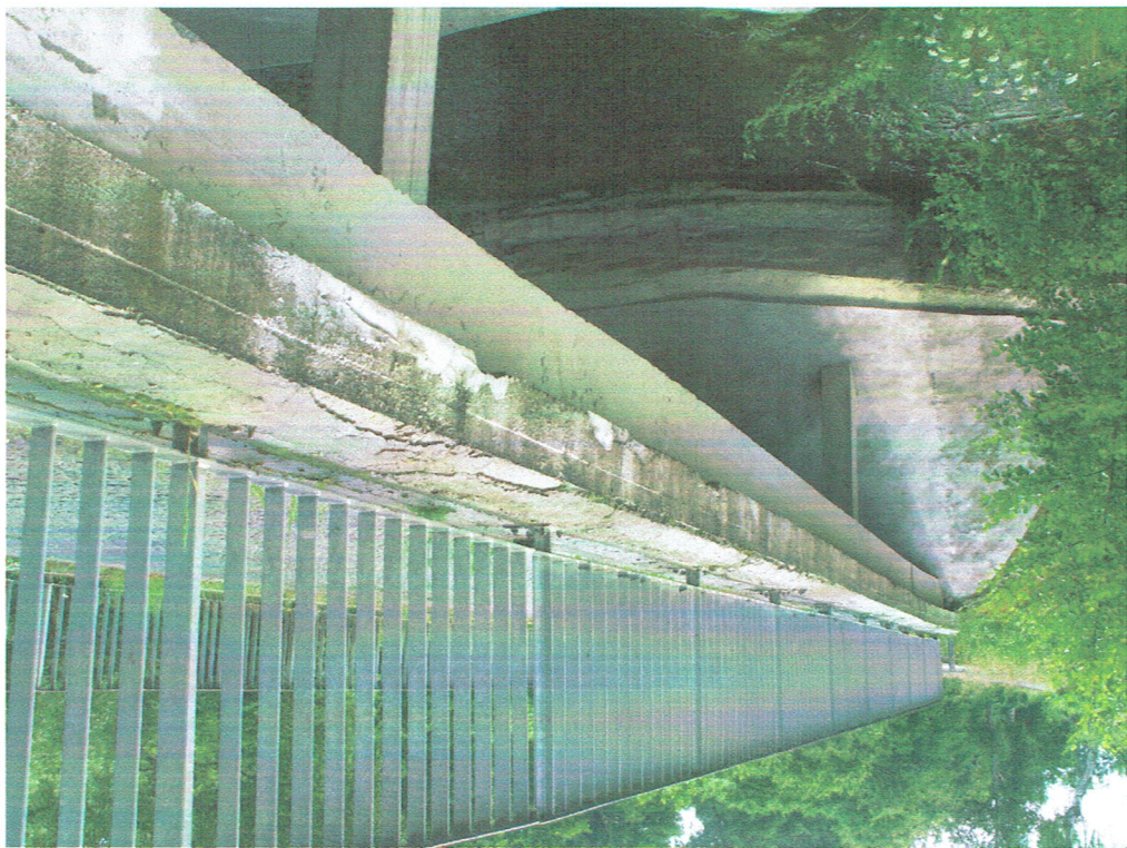
Fot. 7. Korozja betonu na całej długości.
