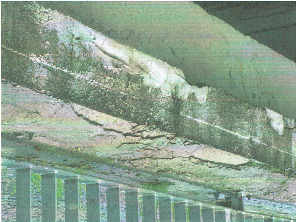
Fot. 8. Ślady lokalnych, niedokończonych napraw ubytków korozyjnych betonu gzymsu.
